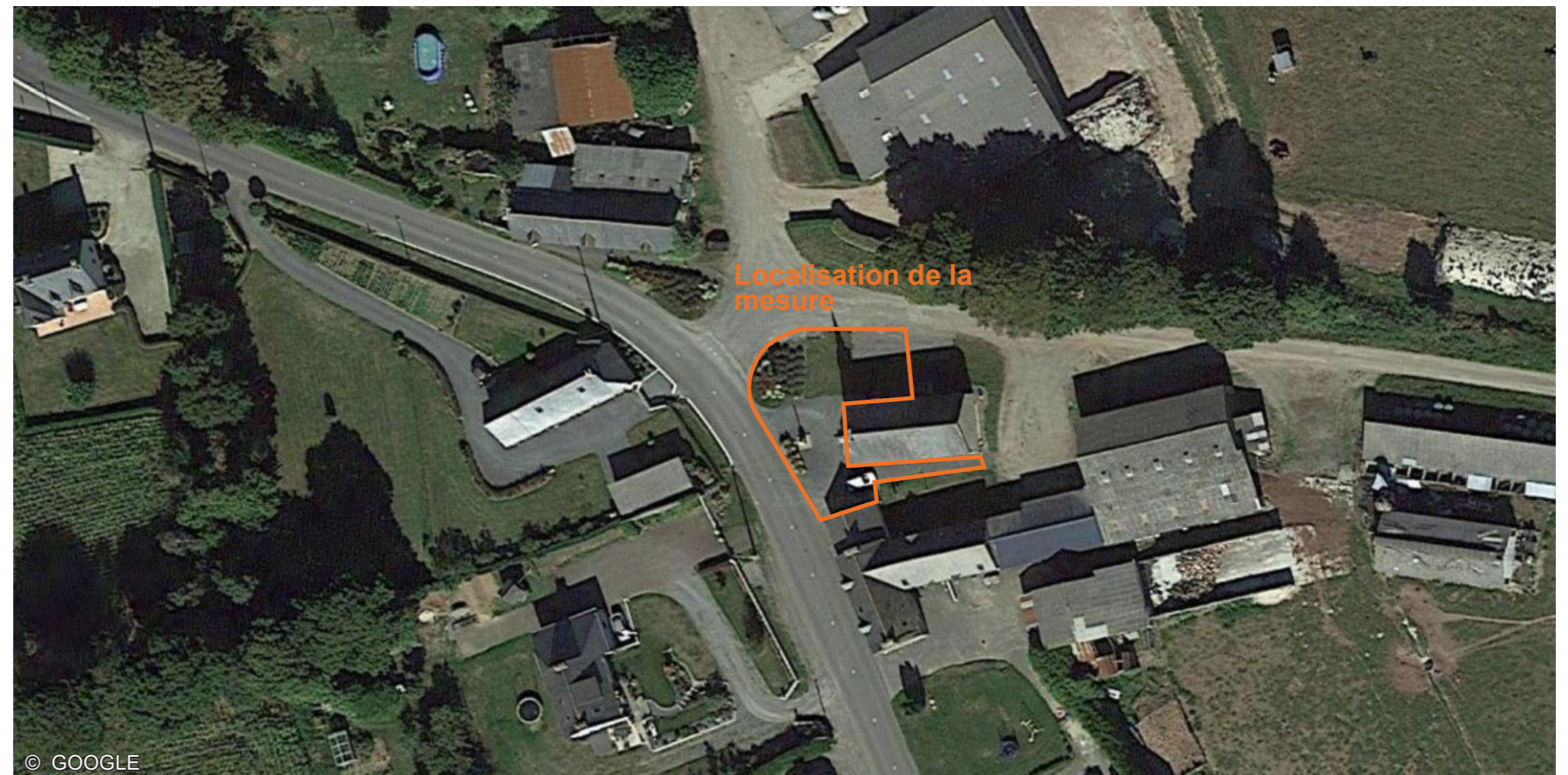
Fig. 220 : Vue aérienne de la chapelle avant le réaménagement
